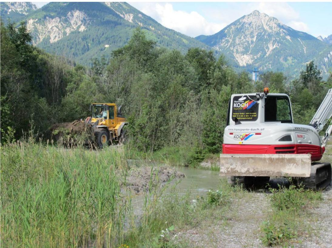
Abb. 5: Im Anschluss Abräumung von Weiden, Schilf und der Schlickauflage mit „schwerem Gerät“ (Kettenbagger Fa. Koch und Radlader Fa. Beirer)
