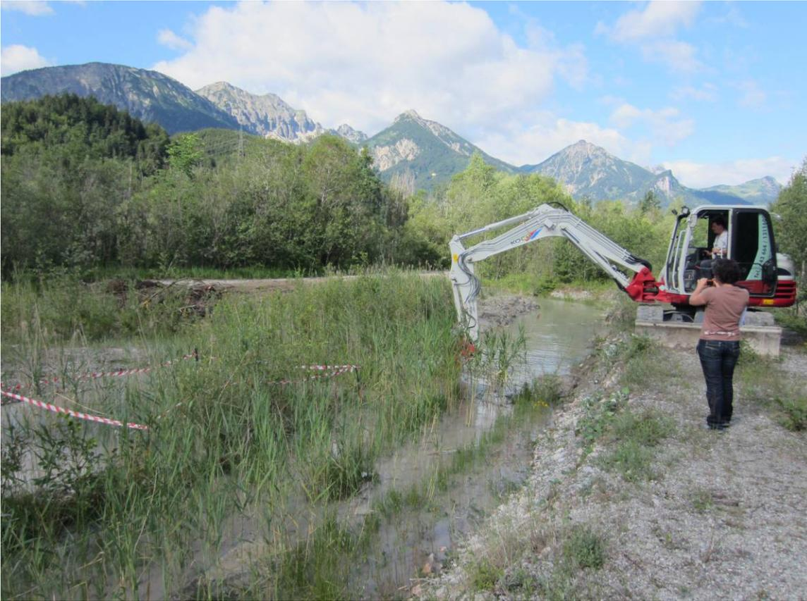
Abb. 6 Auch der aus der Kieswaschanlage führende Graben wurde ausgeräumt, um das Wasserniveau für die in situ Kultur zu verbessern.
