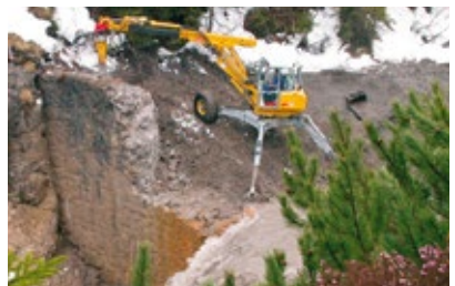
Abbau der Geschiebesperre im Hornbachtal
