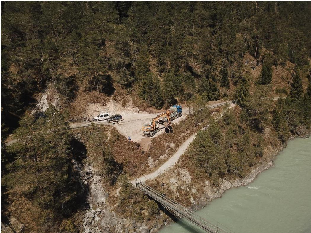
Forchacher Hängebrücke: Die Widerlager für die neue Hängebrücke werden zur Zeit fertiggestellt (Foto: Baubezirksamt Reutte).
